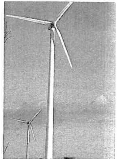
Im Windpark Oberstrahlbach im Bezirk Zwettl wird bereits seit mehreren Jahren saubere Energie erzeugt.
